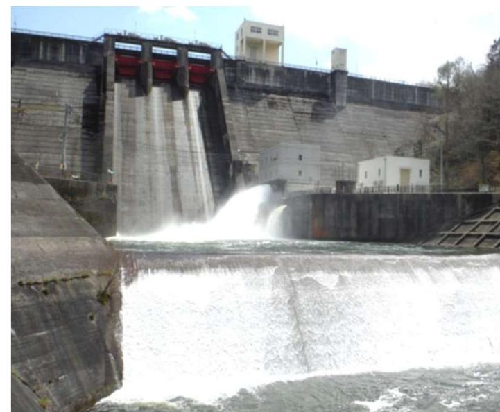
頭首工の耐震化(堰柱の拡幅)
