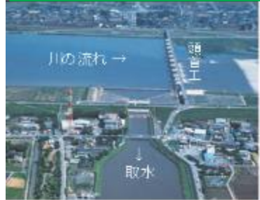
河川からの取水施設 （頭首工）
