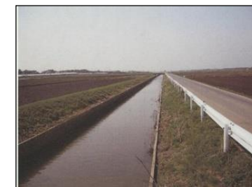
排水路の整備
