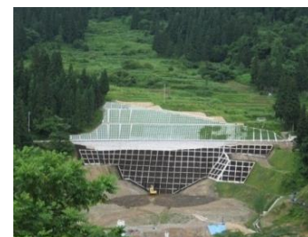
地すべり対策工事の完了
