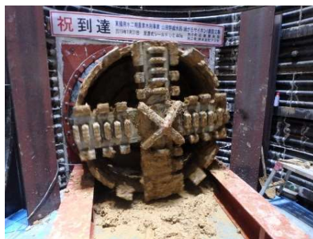
シールド工法による管水路の新設 (内径1.5m、距離2.5km)
