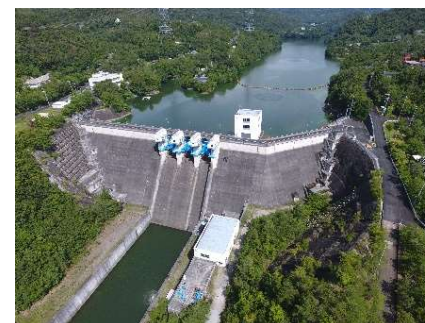
大川瀬ダム (H4完成、重力式コンクリートダム)
