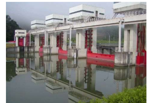
川代ダム (H3完成、ゲート式ダム)
