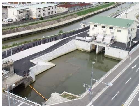
改修後の米田排水機場の外観
