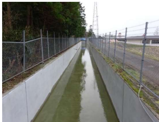
幹線水路（開水路）補修（壁面の表面被覆）
