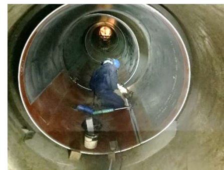
中央幹線水路の補強対策 (内径2m、鋼管巻き込み工法)
