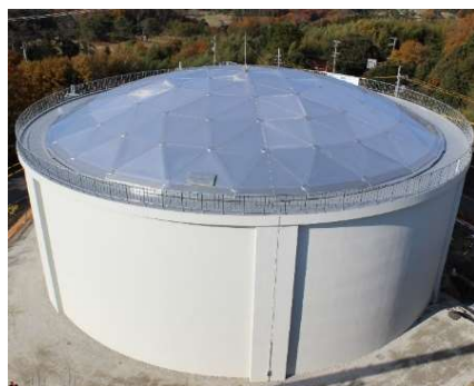
北神戸調整池の新設 (PC円筒式タンク 内径32m、有効水深11m)
