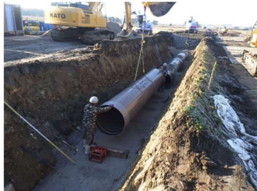
幹線水路（管水路）改修（新管に更新）
