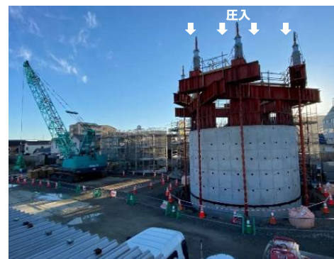
ケーソン圧入による到達立坑の施工 (内径：7m、深さ：19m)
