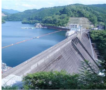
津風呂ダム (S36完成、重力式コンクリートダム)
