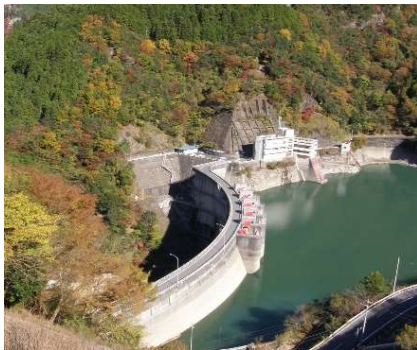
大迫ダム (S48完成、アーチダム)
