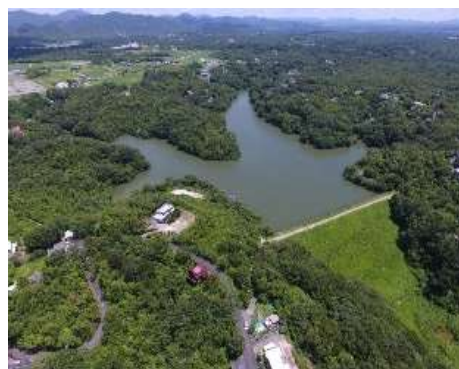
安政池（中心コア型フィルダム） （堤高29m、貯水量680千m 3 ）
