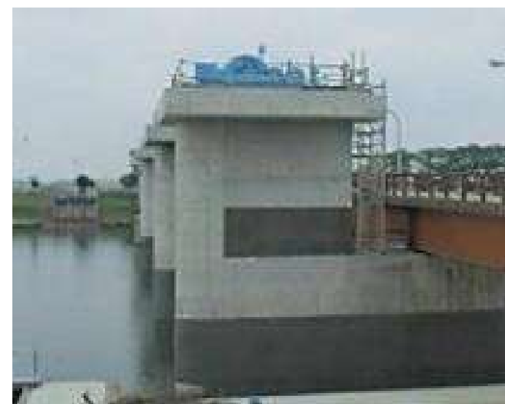
頭首工の耐震化(堰柱の拡幅)
