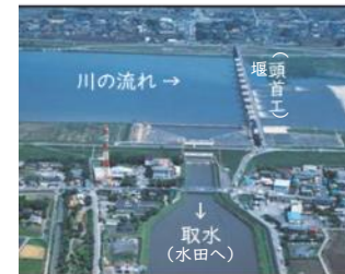
河川からの取水施設 （頭首工）
