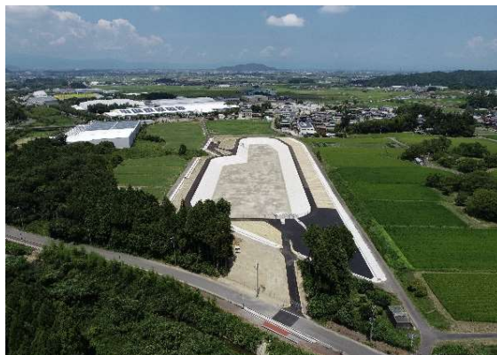
愛知 1 調整池（造成状況）*R5完成
