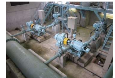
揚水機（ポンプ）の分解・整備
