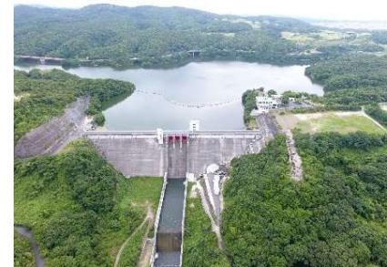
吞吐ダム (H4完成、重力式コンクリートダム)
