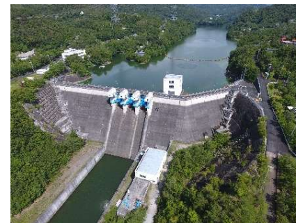
大川瀬ダム (H4完成、重力式コンクリートダム)
