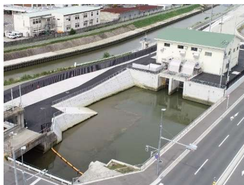
改修後の米田排水機場の外観
