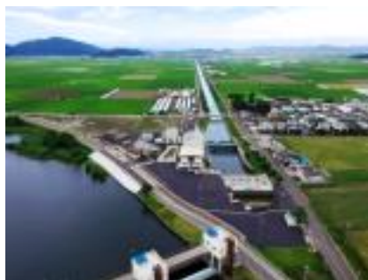
排水施設の整備(排水機場)
