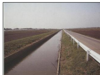
排水路の整備
