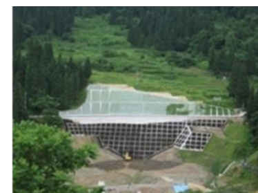
地すべり対策工事の完了
