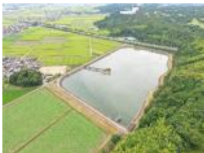
用水施設の整備 (調整池)
