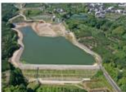
国営総合農地防災事業 和歌山平野地区大瀧池(改修後)【和歌山県紀の川市】
