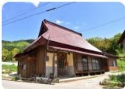
古民家再生（農泊施設）
