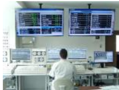
施設の管理 (ダム)
