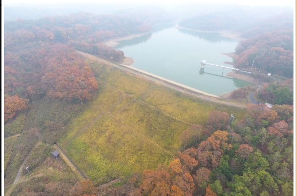
「国営かんがい排水事業 東条川二期地区(全体実施設計)」
