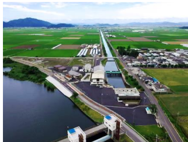
排水施設の整備(排水機場)
