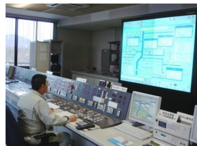
施設の管理(ダム)
