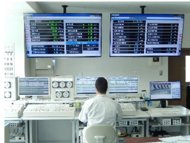
施設の管理(ダム)
