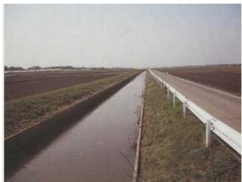
排水路の整備
