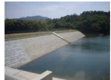
整備されたため池
