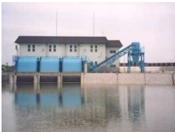
排水機場の整備
