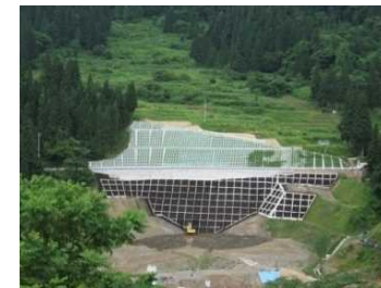
地すべり対策工事の完了
