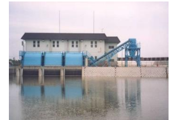
排水機場の整備
