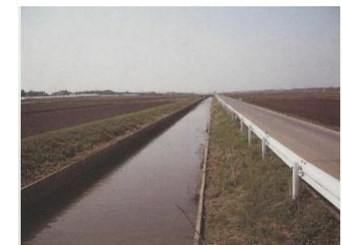
排水路の整備
