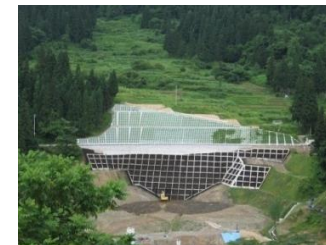
地すべり対策工事の完了
