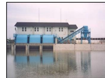
排水機場の整備
