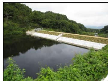
整備後のため池
