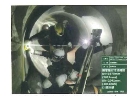
現場監督（鋼管据付寸法の確認）
