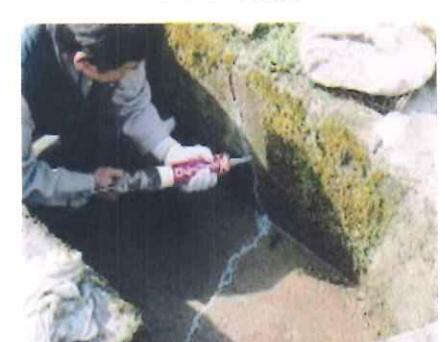
水路のひび割れ補修
