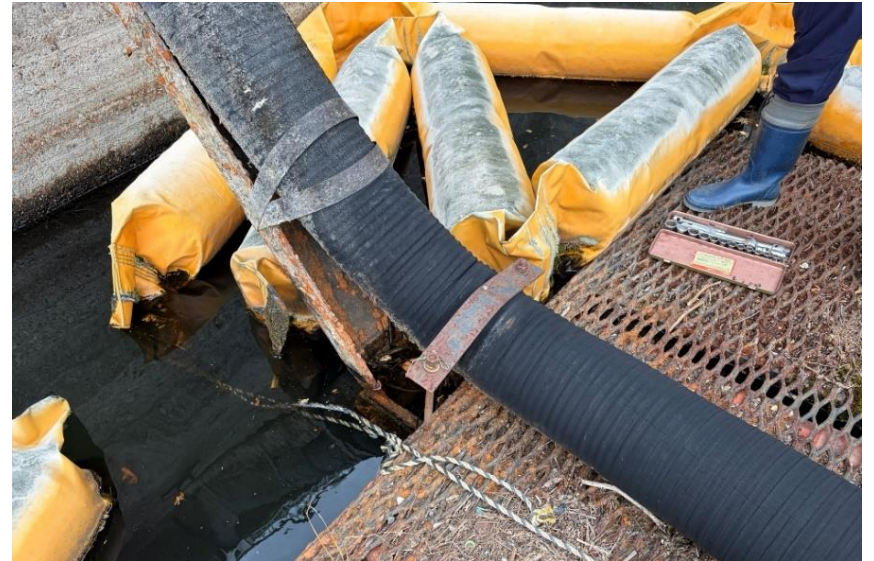
切断前(水中ポンプ・筏場状況)
