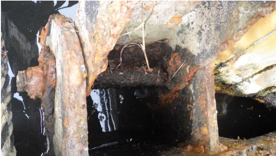
切断前(溶接補修・補強対象鋼材)
