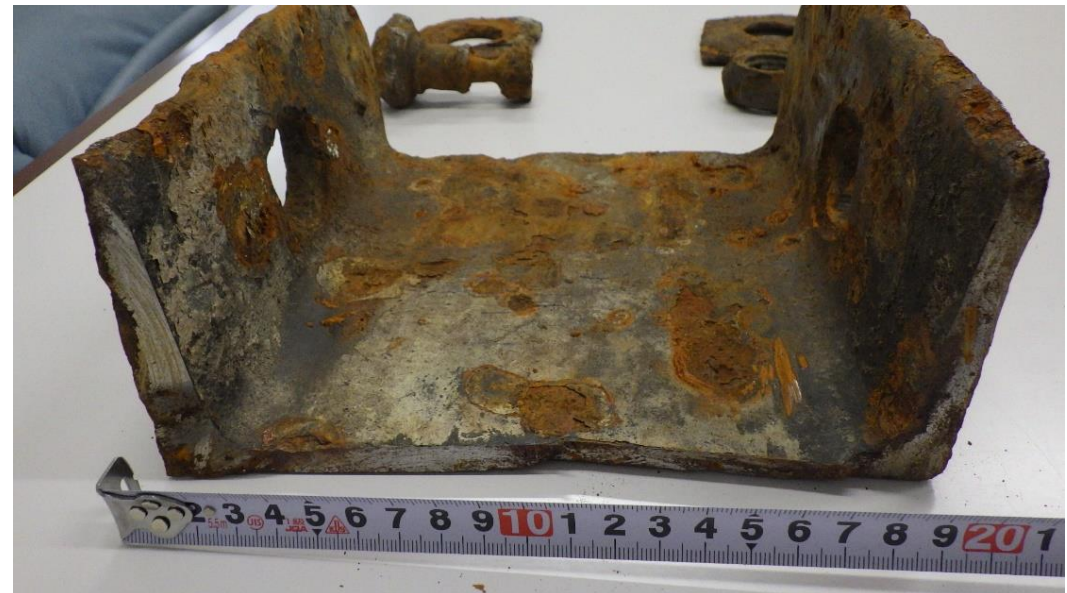
切断後_現況(溶接補修・補強対象鋼材)
