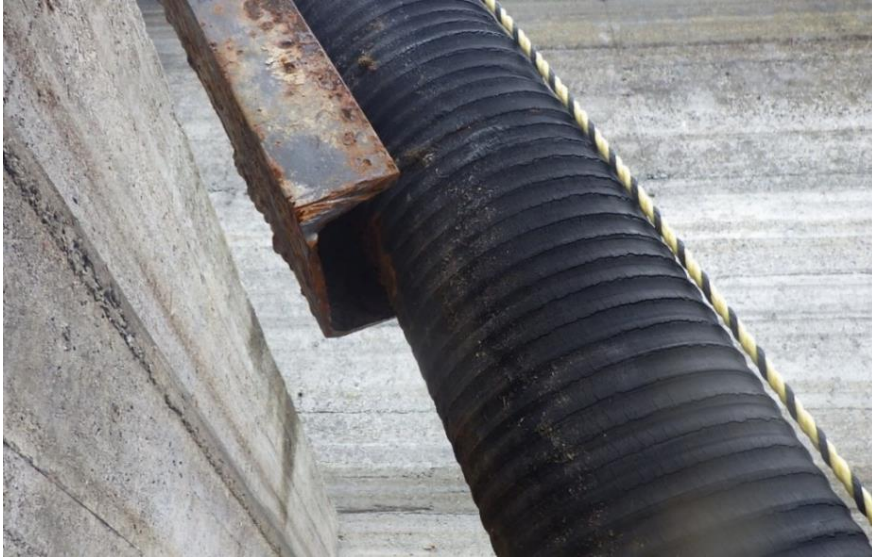
切断後_現況(溶接補修・補強対象鋼材)
