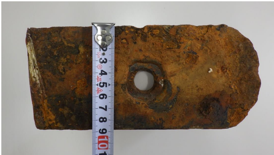
切断後_現況(溶接補修・補強対象鋼材)
