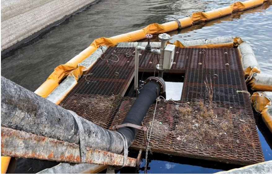
切断前(水中ポンプ・筏場状況)
