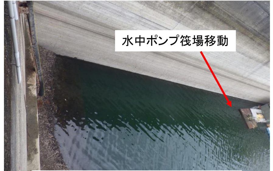
切断後_現況(水中ポンプ・筏場状況)
