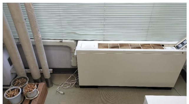
東側配管付近
