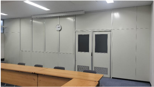
上貼り面全景
