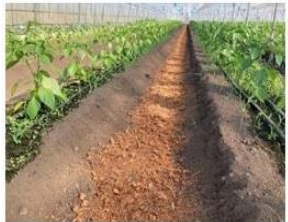
スーパーベラポン敷設
