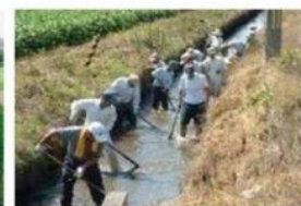
水路の土砂さらい
