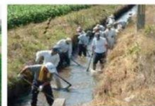
水路の土砂さらい
