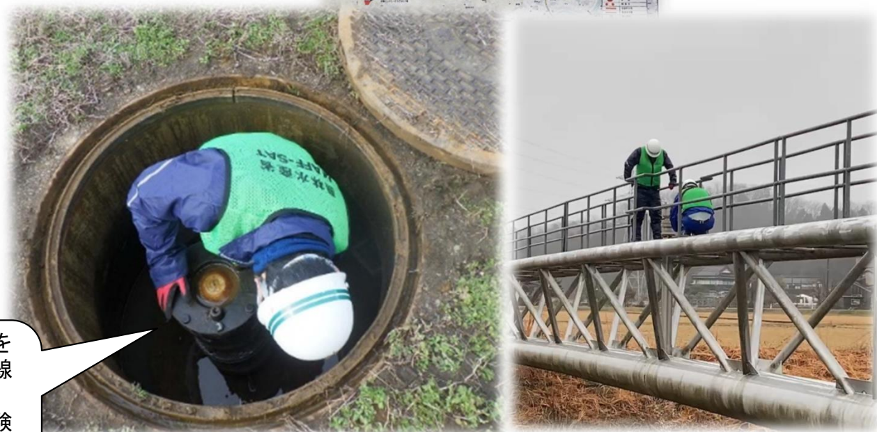
パイプラインの被災状況確認・充水試験の様子
