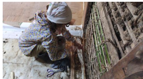
古民家改修作業の様子
