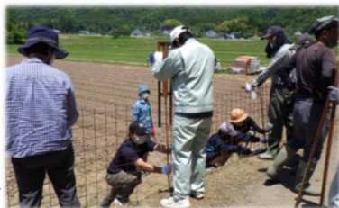
関係人口による獣害防護柵の設置
