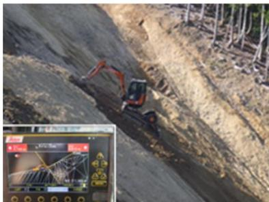
近畿中国森林管理局 兵庫森林管理署は、降雪等の影響により施工時期に制限がある地域や侵食が進行して危険度が増した山腹崩壊斜面において、効率性と安全性を確保・向上させた施工体制を構築するために、ICT法面掘削技術の導入を図りました。
