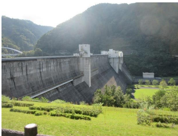
地域に開かれたダムとして親しまれている日吉ダム
