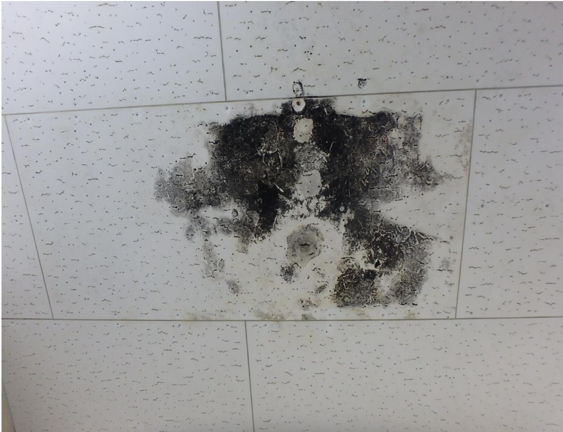
天井板腐食、床の水滴
