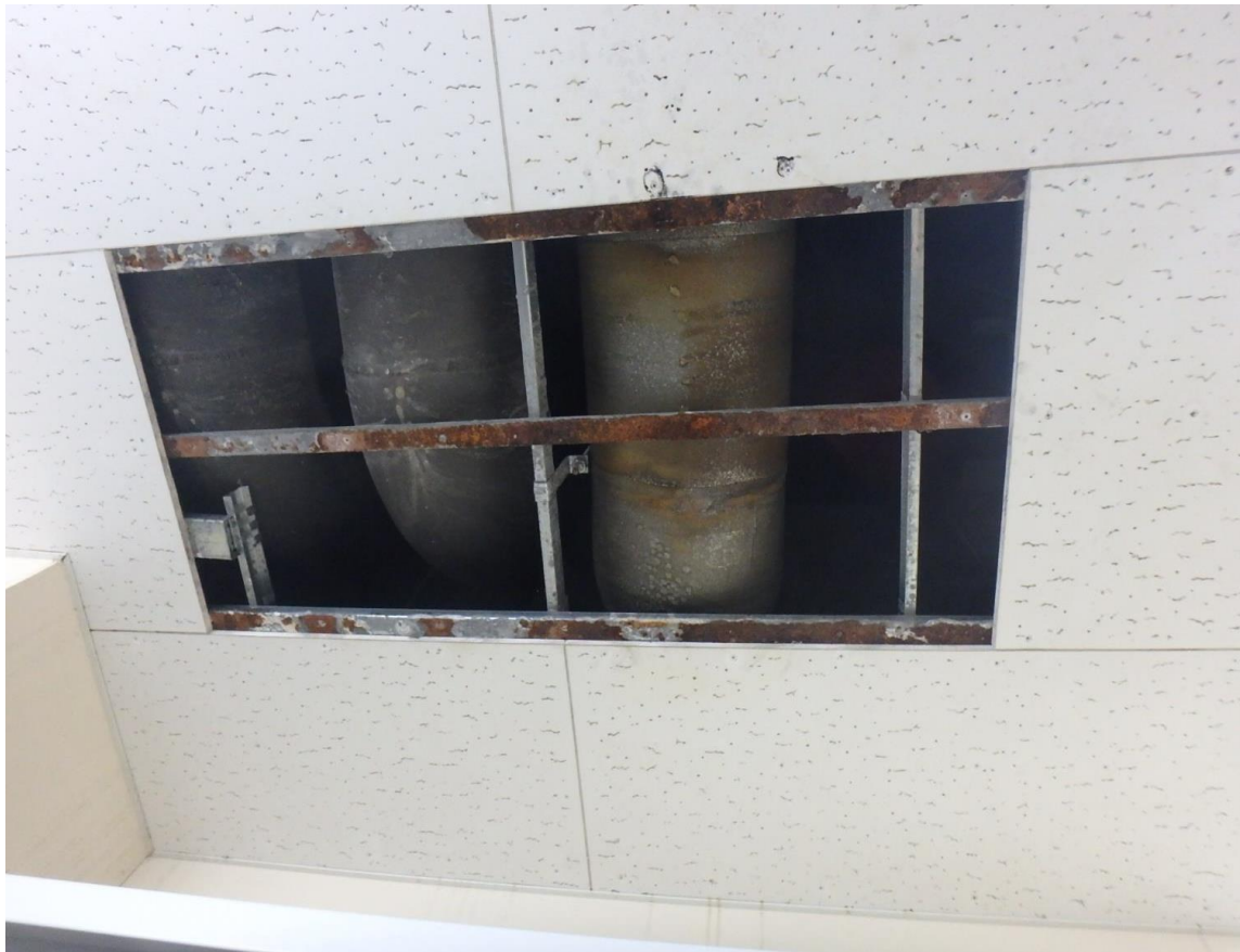
冷温水配管結露
