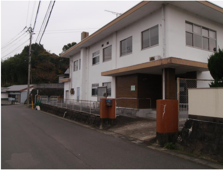
庁舎入口外観
