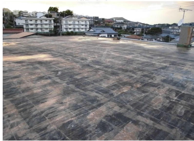
庁舎屋上（現況）
