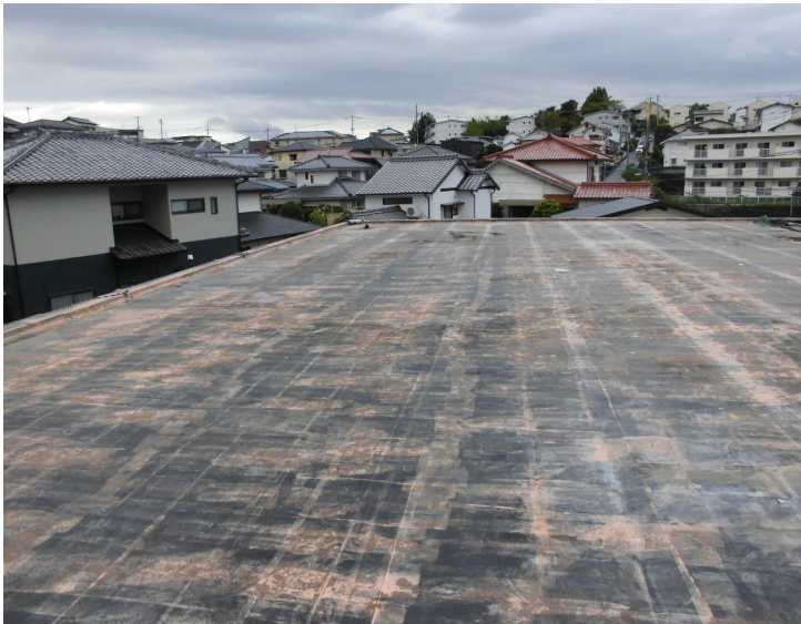
庁舎屋上（現況）
