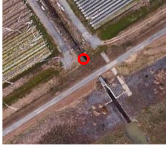
②小江干拓地排水路(2号樋管)
