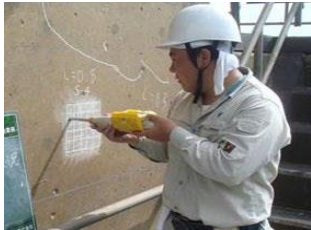
老朽化した施設の機能診断
