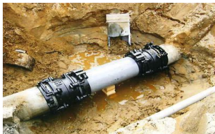
漏水防止のための整備
