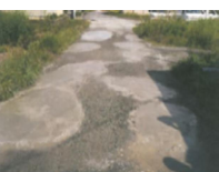
農道の窪みの補修
