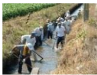
水路の泥上げ
