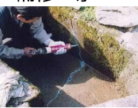
水路のひび割れ補修
