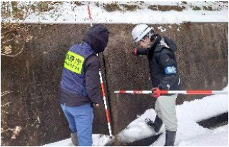
激甚災害後の治山施設の点検支援
