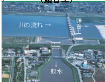
河川からの取水施設 （頭首工）
