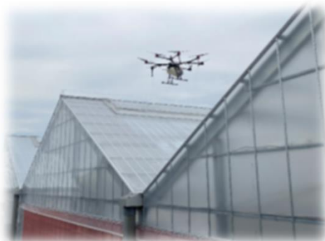
ドローンによる遮光剤塗布
