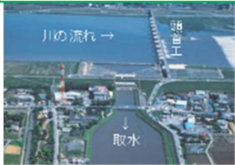
河川からの取水施設 （頭首工）
