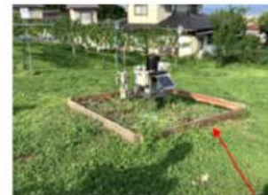
侵入防止柵の設置
