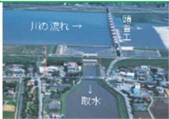
河川からの取水施設 （頭首工）
