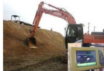
ICTバックホウによる暗渠排水掘削・法面整形
