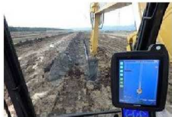
ICTバックホウによる暗渠排水掘削・法面整形
