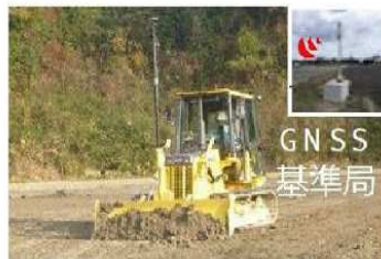
ICTブルドーザによる整地
