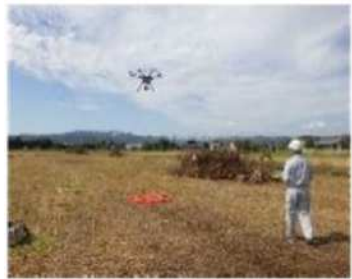
UAV等による起工測量
