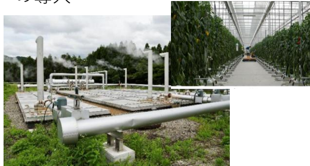
温泉熱を利用した加温システムの導入
