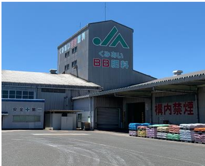
(株) JA物流かごしま 肥料工場
