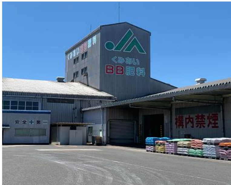
(株) JA物流かごしま 肥料工場
