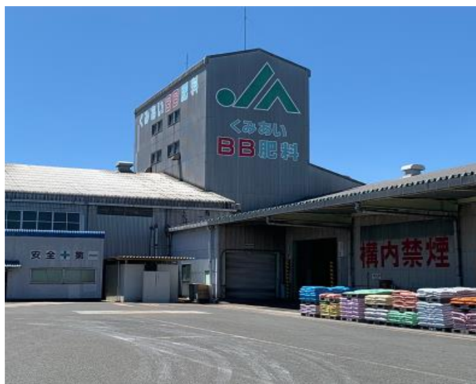
(株) JA物流かごしま 肥料工場
