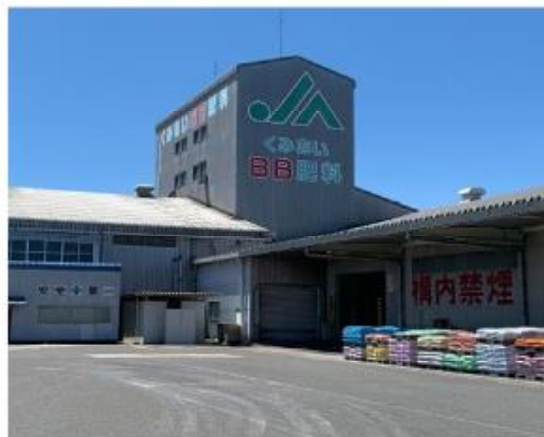
(株) JA物流かごしま 肥料工場
