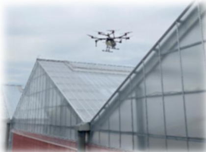
ドローンによる遮光剤塗布
