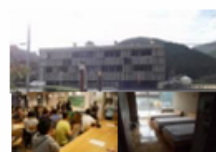
廃校を利用した交流施設
