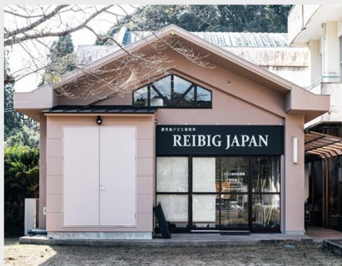
建屋 (処理加工施設)
