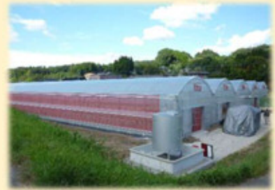
新設したハウス
