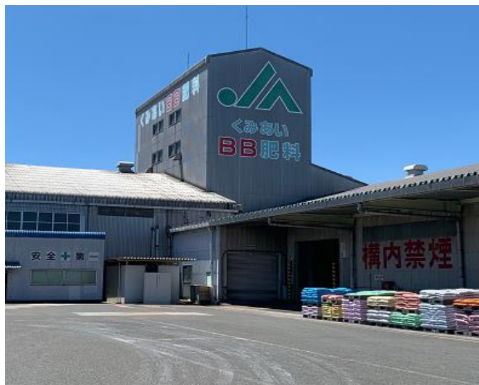
(株) JA物流かごしま 肥料工場
