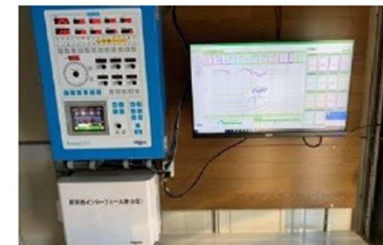
施設園芸:統合環境制御装置
