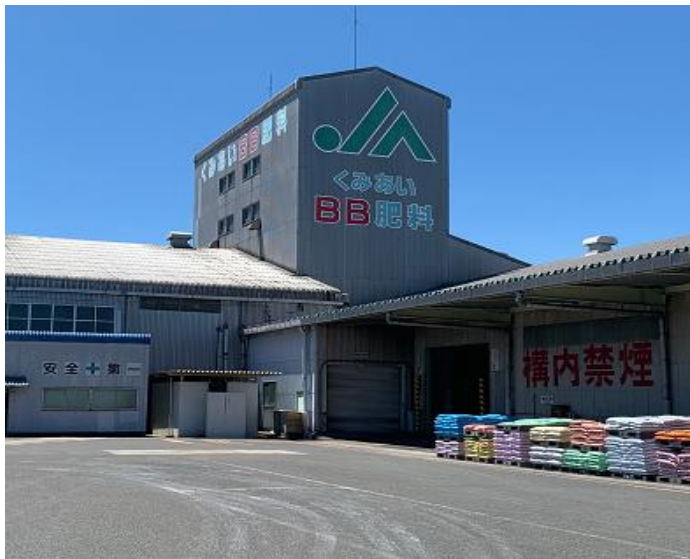
(株) JA物流かごしま 肥料工場
