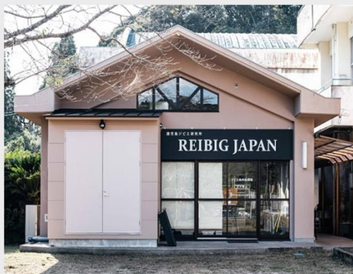
建屋 (処理加工施設)
