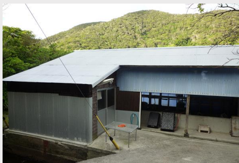
廃屋をリノベーションした建屋
