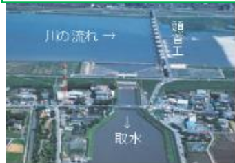
河川からの取水施設 (頭首工)
